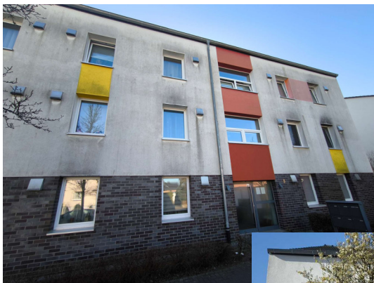
Beispiel anhand der Häuser Fredestraße 7, 9 in Kleve vor und nach der Fassadenreinigung
