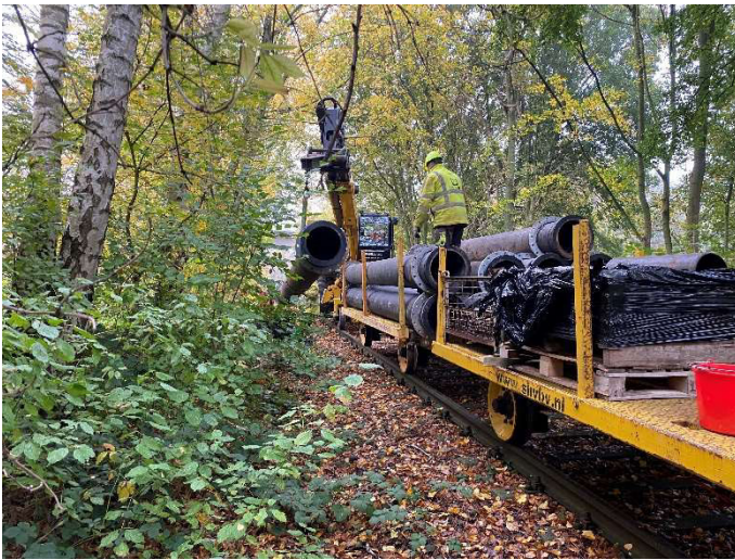
Für die Wasserhaltung wurden die Entwässerungsrohre mithilfe eines Gleisfahrzeuges neben der Draisinenstrecke verlegt und das Grundwasser in die Spoy eingeleitet
